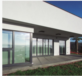
Passiivitalo. Asuinrakennus. Miño, Espanja. Aquarea.
