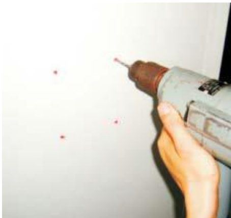
Aukko porataan sähköporalla.
