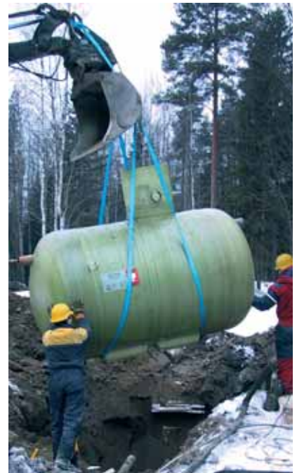
Labko BioKem 10 EN ja 15 EN -puhdistamoiden valmistusmateriaali on kestävä lujitemuovi.
