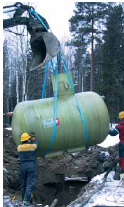
Labko BioKem 10 ja 15 -puhdistamoiden valmistusmateriaali on kestävä lujitemuovi.
