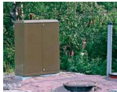
Labko BioKem 20...90 -malleissa puhdistamon toimintaa ohjaava keskusyksikkö sijaitsee puhdistamon läheisyyteen asennettavassa laitekaapissa.
