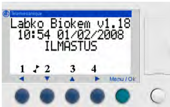
Kuva 5. Zelio- ohjausrele BioKem panospuhdistamossa RUN -tilassa.
