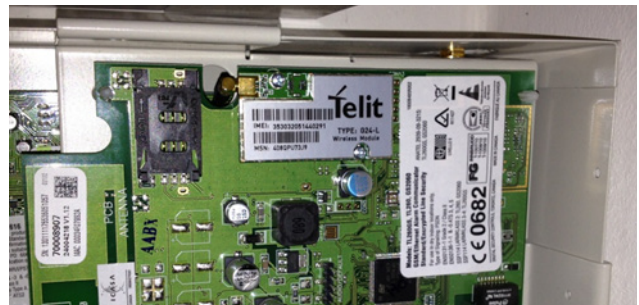
Kuva 8. Asennuskehikon asettaminen keskusoteloon.
