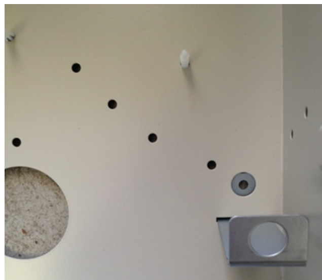
Kuva 2. Kansisuojan kannatinraudan asennus.
