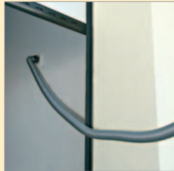
Autotalliin asennettu imurasia
