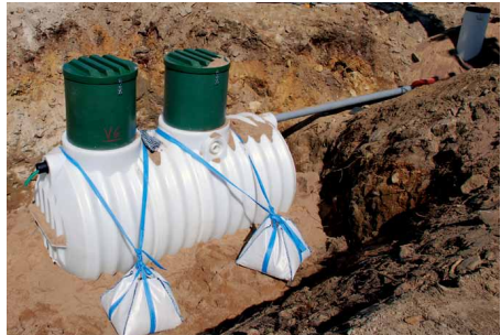
Kuva 9. Säiliön ankkurointi
