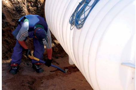
Kuva 8. Säiliön asettaminen kaivantoon
