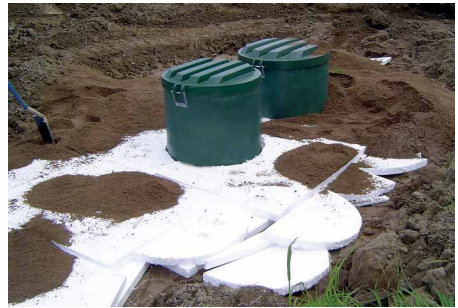
Kuva 12. Säilön eristekerros
