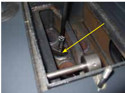
7. Nuohoa konvektiotuubien pinnat pyöreällä harjalla ja poista lentotuhka. Työnnä harja alas asti ja nosta takaisin ylös.
