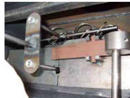
9. Asenna konvektiokanavan kannet ja keinuvipu paikoilleen.
