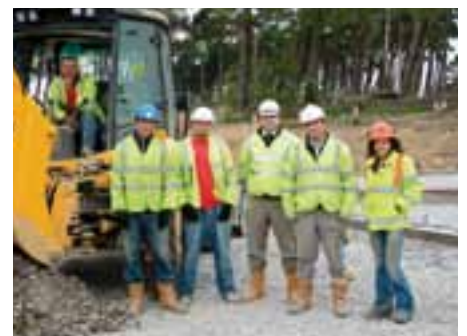
Tensar suunnittelee urakoitsijoiden hyödyksi ja antaa tarvittavat asennustekniset neuvot.
