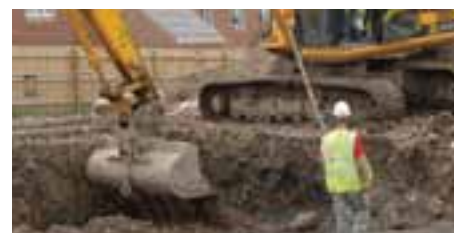
Maa-ainesta asennetaan TriAx-geoverkon päälle ennen lopullista tiivistystä.
