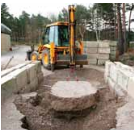
TriAx'ia kaivetaan ylös TRL:n tekemissä asennusaikaisen vaurioitumisen arvioinneissa.
