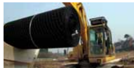
TriAx-geoverkko on käsiteltävissä koneellisesti tai kahden miehen kannettavissa.
