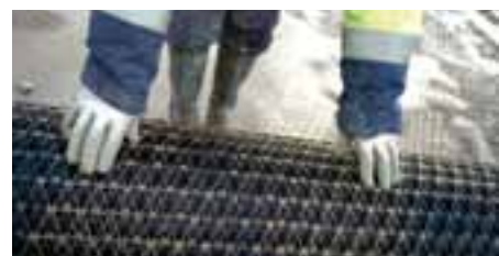
TriAx-geoverkko avaamattomana työmaalla.
