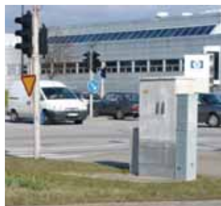
Liikennevalojen automaattilaitteiden jakokaappi Ruotsissa Malmössä
