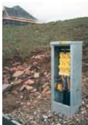
Englannin Bristolissa oleva jakokaappi, jolla on korvattu tavallinen maanalainen kaapelinpääte.
