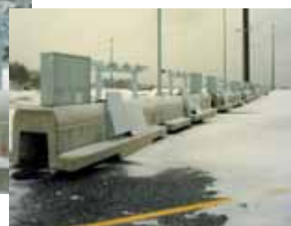
Ruotsiin Göteborgin satamaan asetettujen kylmäsäiliöiden jakokeskukset
