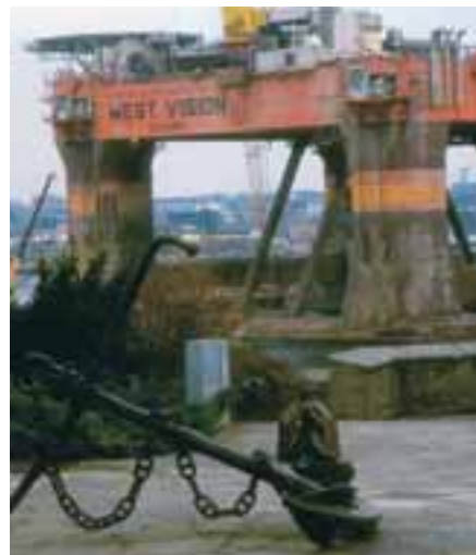
Kaapelijakokaappi öljynporauslautan vieressä Norjan Stavangerissa
