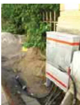
Kabeldonin laitteet syöttävät virtaa rantakadun valaistukselle ja ohjaavat sitä Englannin Blackpoolissa.
