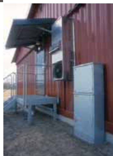
Telarakennuksen sähkönjakelukeskus
