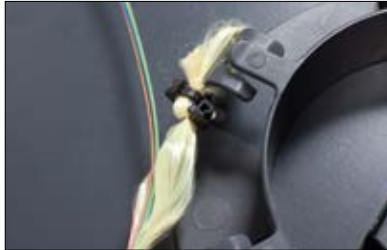
2. Poista kuitukaapelista veto kiinnittämällä kevlar-osa kuidunpitimeen.
