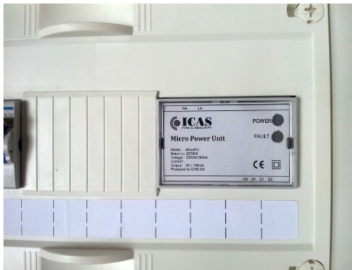
Icas Micro-Pu sähkökeskukseen asennettava virtalähde
