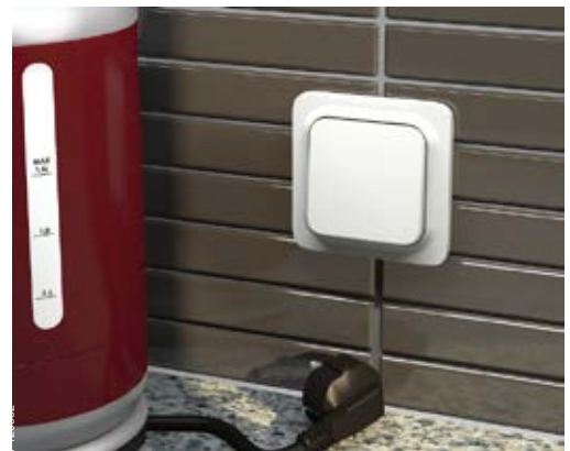
Vanha asennus, jonka paikalle tarvitaan uusi pistorasia.
