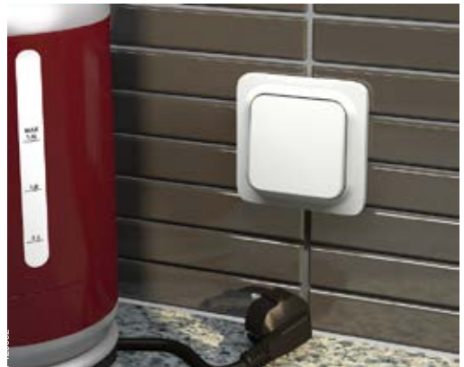
Vanha asennus, jonka paikalle tarvitaan uusi pistorasia.
