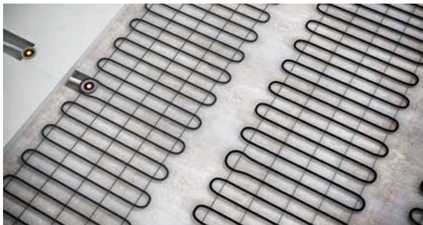
Lumi- ja jääanturi asennetaan lämmitettävän alueen ulkopuolelle ja lämpötila ja kosteusanturi lämmitet- tävälle alueelle. (KUVA OHJEELLINEN)
