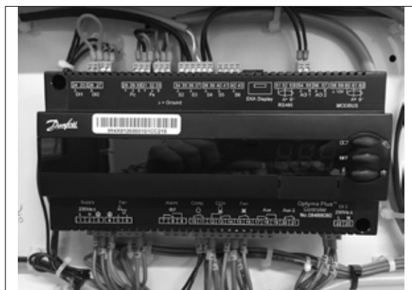
Bild 4: Normale Verdrahtung
