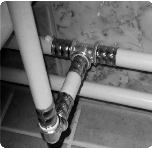
WehoPress-käyttövesiputkien haaroittaminen.
