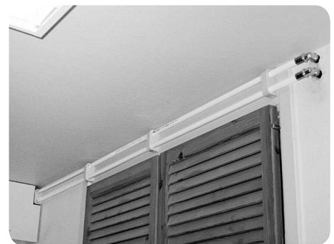
WehoPress-lämpöjohdot yläjakoisena 2-putkijärjestelmänä.
