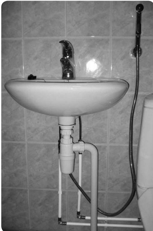
Pinta-asennetut WehoPress-kytkentäjohdot pesuallalle.
