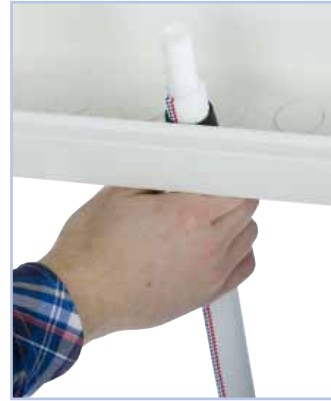
Työnnä suojaputki ja PEX-putki holkin läpi.
