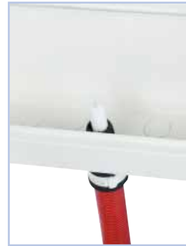
Työnnä PEX-putki kaapin sisälle.
