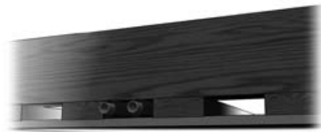
Esimerkki putkien sijoittamisesta katon harvalaudoitukseen.
