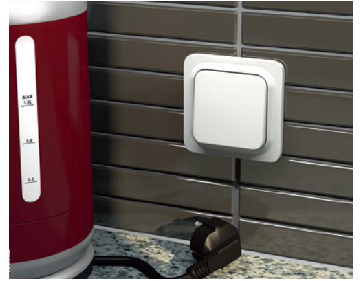
Vanha asennus, jonka paikalle tarvitaan uusi pistorasia.
