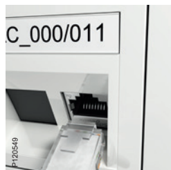
Liittimet käännetty johtojen irrottamisen helpottamiseksi.
