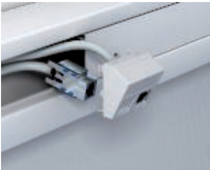
Liittimen kiinnitys kanavatarasiaan Valmis tietoverkkoliitin sijoitetaan takaa kanavakalusteeseen. Liittimen asennuslevy painetaan verkkokalusteeseen, johon se lukkiutuu.
