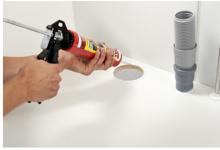
2. Laita silikonilla huolellisesti aukon ympärille
