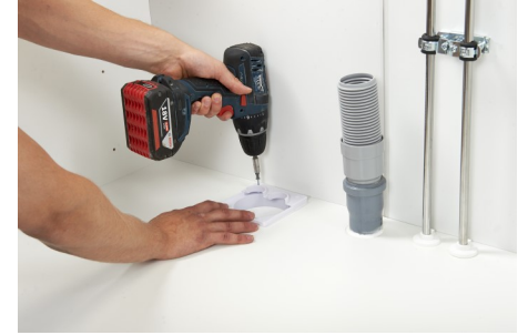
6. Ruuvaa pienempi kansi kiinni pohjan läpi pakkauksen ruuveilla
