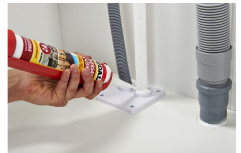
12. Kannakoi letkut sekä viimeistele ja tiivistä läpivienti huolellisesti silikonilla
