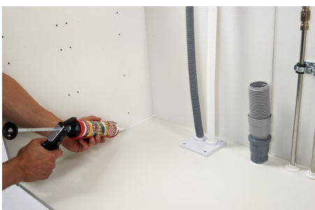
13. Tiivistä allaskaappi ja muut mahdolliset läpiviennit silikonilla rakennusmääräysten mukaisesti (C2)
