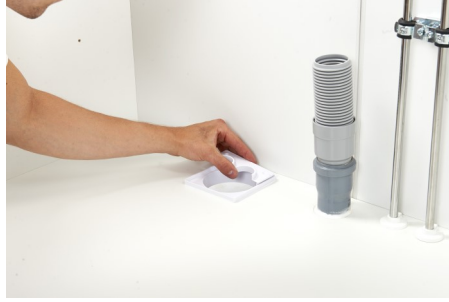
5. Aseta pienempi kansi paikoilleen pohjan takaosaan
