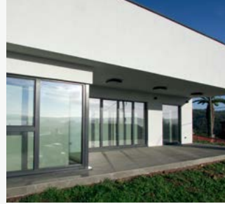
Passiivitalo. Asuinrakennus. Miño, Espanja. Aquarea.
