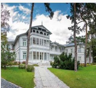
Gurewicz Spa Resort. Kylpylähotelli ja ravintola. Otwock, Puola. PACi, VRF ja ohjaus.
