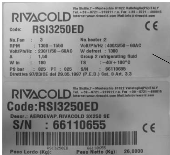
Figura 1 – Targa di identificazione.
