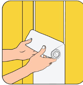
4. Poista teipistä suojanauha ja kiinnitä suodatinkangas pyöräyttämällä kangas alhaalta ylös. Paina suodatinkangasta huolellisesti, jotta se kiinnittyy hyvin.
