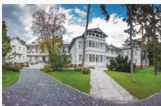
Gurewicz Spa Resort. Kylpylähotelli ja ravintola. Otrock, Puola. PACi, VRF ja ohjaus.
