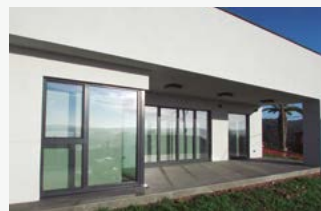
Passiivitalo. Asuinrakennus. Miño, Espanja. Aquarea.
