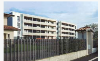
Crosslight House. Asuinrakennus. Mulazzano, Italia. PACi ja nanoe™ X.
