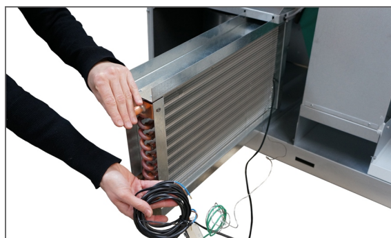
2. Laitakana jälkilämmitin asennetaan ja työnnetään uraansa sekä ylhäällä että alhaalla, vesikytkennät osoittavat ulospäin. Samaan aikaan termostaatin ja tulee vetää laitteen etupuolelle.
