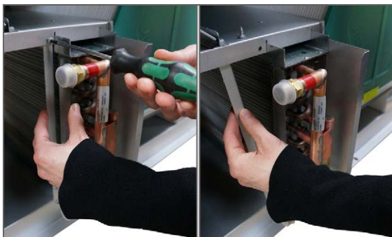
3. Joissakin laitteissa on ohjainlevy joka tulee poistaa ennen patterin asennusta, muuten vesiputket ottavat siihen kiinni.
