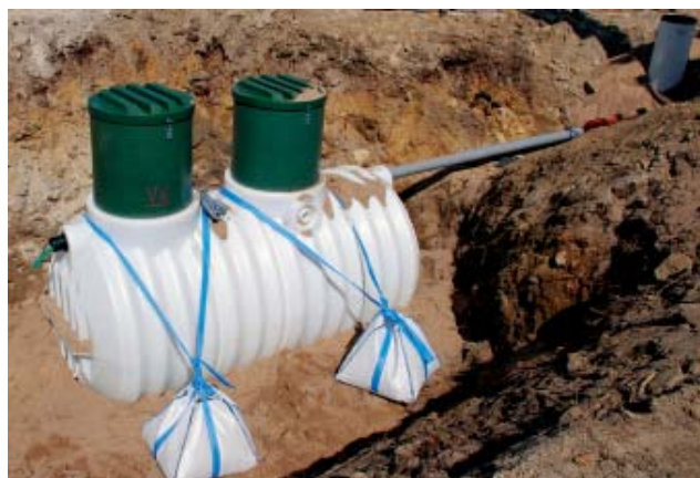
Kuva 9. Säiliön ankkurointi
