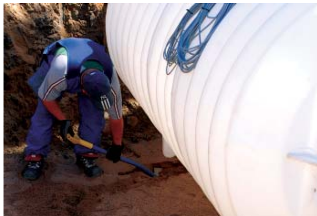
Kuva 8. Säiliön asettaminen kaivantoon
