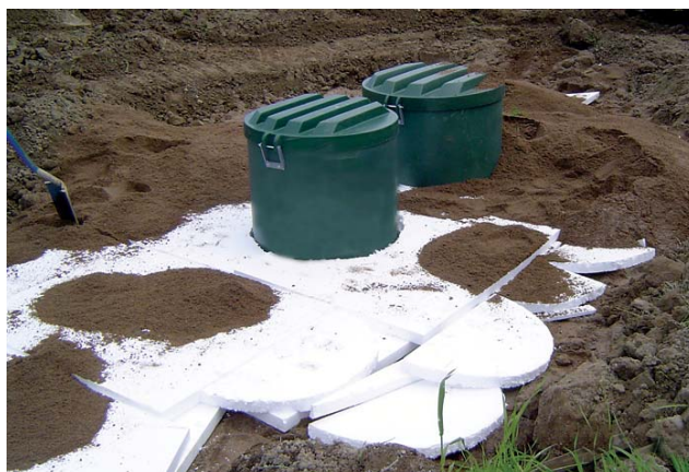
Kuva 12. Säilön eristekerros
