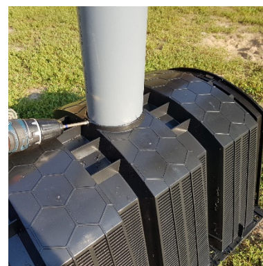
11. Uzstādiet ventilācijas cauruli
