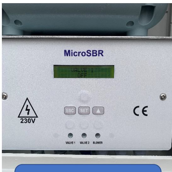
Vārsts 1 Notekūdeņu aerācija - difuzors BALTS
