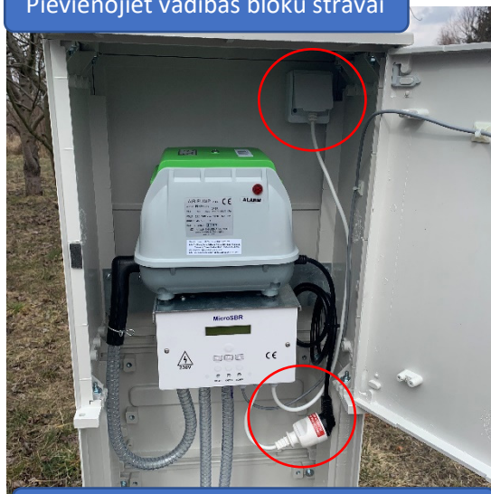
Pievienojiet kompresoru vadības blokam
