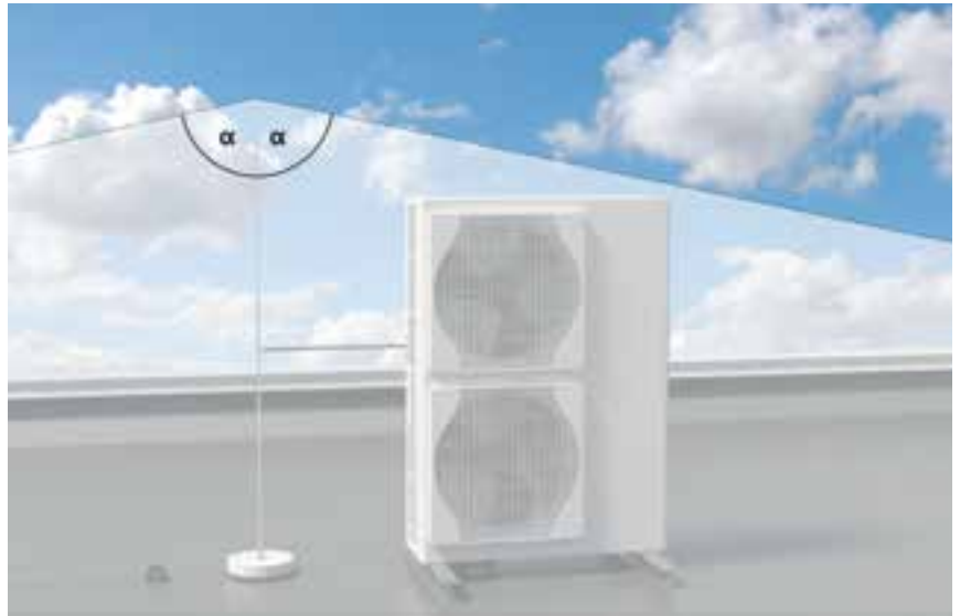
Katolla olevan sähkölaitteen suojaaminen suojakulmamenetelmällä.
