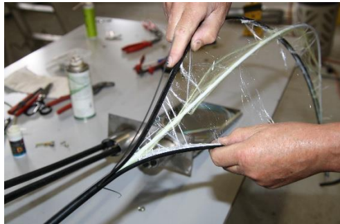
Vedä vaipan puoliskot erilleen ja katkaise ne noin 3 cm:n pituisiksi. Katkaise vaipan alla olevat vahvikkeet.
