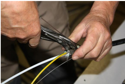
Halkaise vaippa teräslankojen urista käyttäen ST-OCS -vaippakuorijaa.
