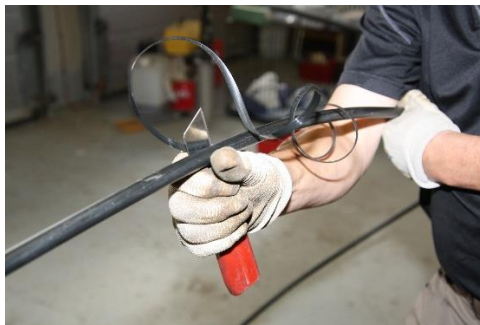
Kuori vaippa pois teräslankojen päältä koko kuorittavalta pituudelta.
