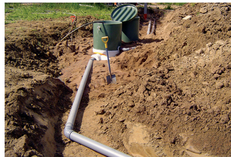
Kuva 11. Panospuhdistamon purkuputki
