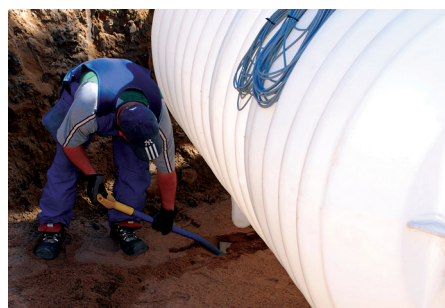
Kuva 8. Säiliön asettaminen kaivantoon
