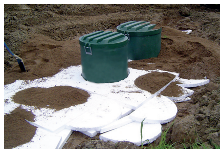
Kuva 12. Säiliön eristekerros
