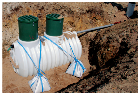
Kuva 9. Säiliön ankkurointi
