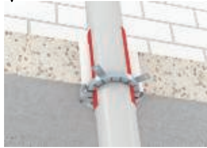
Montage an der Deckenunterseite mit Metalldübeln
