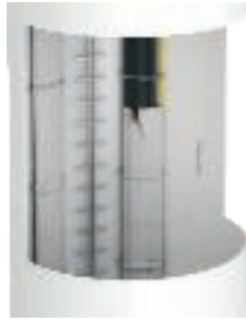
Bandagierte Steigetrasse im Turm einer Windkraftanlage
