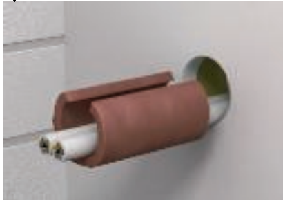
Bei bereits installierten Kabeln Aufschneiden der Rohrschale
