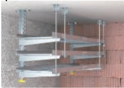
Deckenmontage mit einseitiger Anordnung der Ausleger
