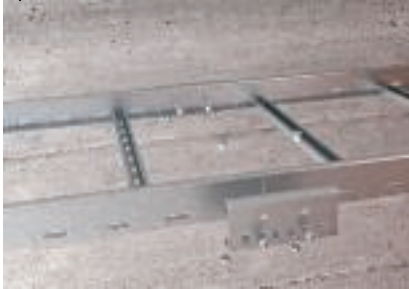
Montage der Längsverbinder mit Flachrundschraben
