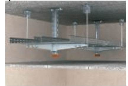
Zweilagige Deckenabhangung mit beidseitiger Auslegeranordnung
