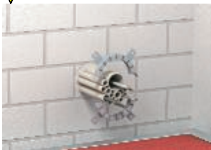
Zusammenstecken der Manschettenhälften und Befestigen an der Wand
