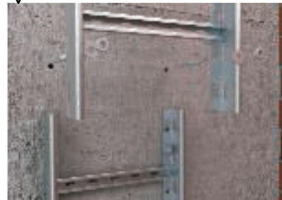
Stoßstellenausführung ohne Verbinder
