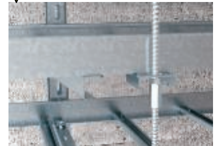
Gewindestangenmontage bei mehrlagiger Trassenanordnung
