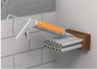
Abschließender Fugenverschluss bei Vollbelegung mit Kabel
