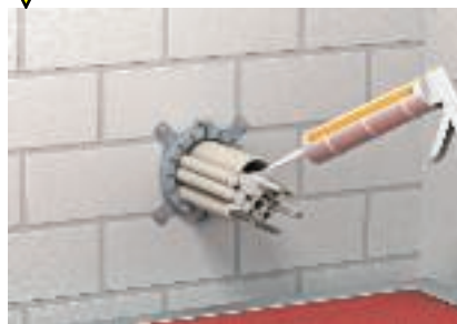
Verschließen der Rohrenden mit Dämmschichtbildner DSX
