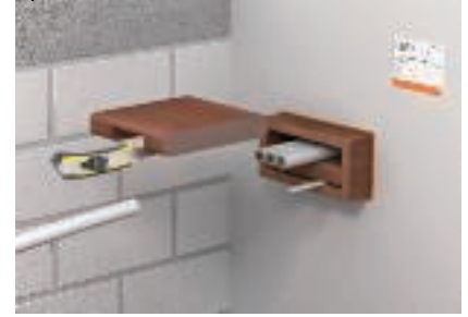
Passgenaues Zuschneiden der Innenstücke und einsetzen in den Rahmen
