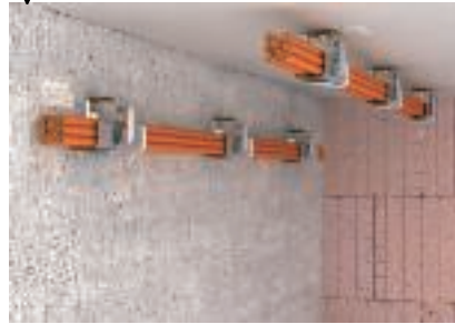
Montage der Sammelhalterung 2031 M 15 mit Langwanne
