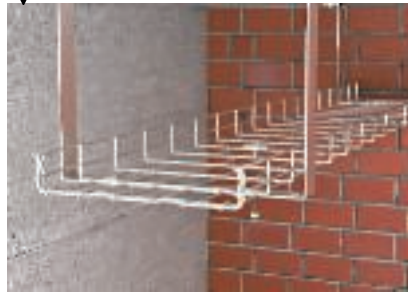
Befestigung der Gitterrinne mit Klemmstück und Flachrundschaublen
