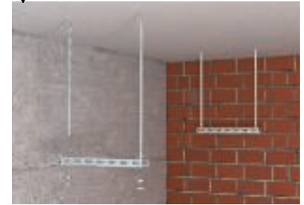
Gewindestangenmontage mit Sechskantmuttern und großen Unterlegscheiben
