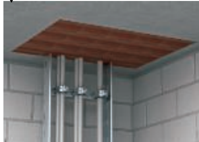
Strammsitzender Einbau der Blöcke im Deckendurchbruch
