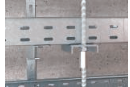
Gewindestangenbefestigung an der Rinne bei mehrlagiger Anordnung
