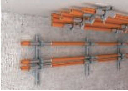
Waagerechte Montage mit Bügelschellen und Langwannen an der Wand und unter der Decke
