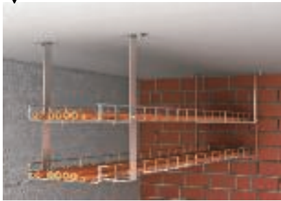
Zweilagige Deckenmontage mit Abhängebügel und Verlängerung
