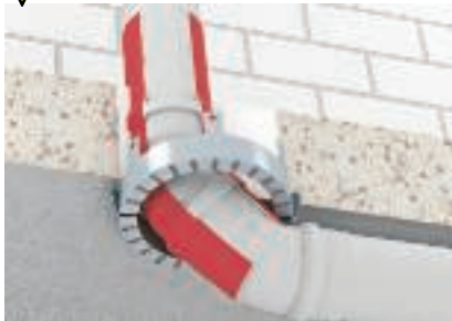
Rohrmuffen im Bereich der Durchführung
