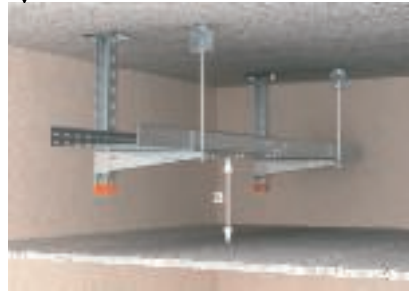
Erforderlicher Mindestabstand zur Brandschutzdecke
