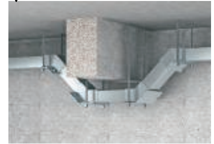
Abgehängte Montage mit Vertikalbögen
