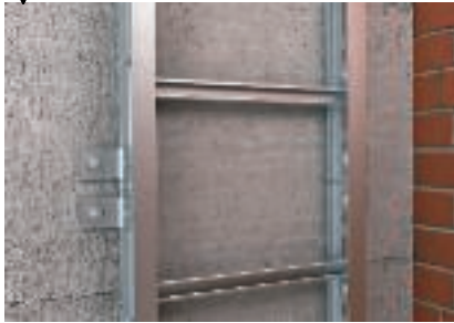
Direkte Montage der Steigeleiter an der Massivwand
