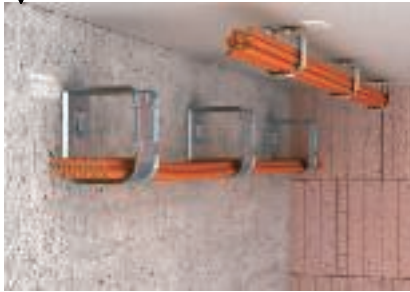
Waagerechte Wand- und Deckenmontage
