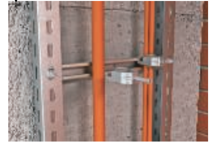
Installation der Kabel mit Bügelschellen, auch mit Mehrfachbelegung möglich
