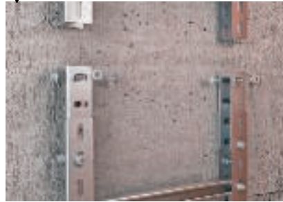
Stoßstellenausführung mit verschraubtem Verbinder
