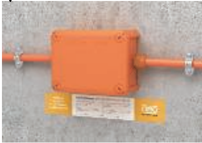
Fertig installierte FireBox mit Kennzeichnungsschild
