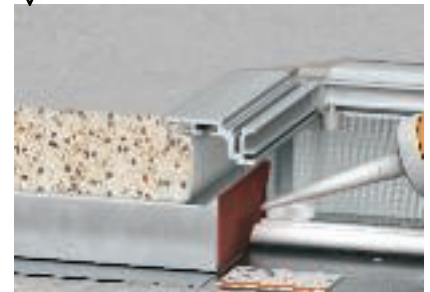
Fugen zwischen Kabeln und Blöcken mit Spachtelmasse FBA-SP verschließen
