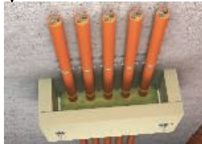
Wirksame Unterstützungsmaßnahme mit der Zugentlastung ZSE90
