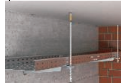
Deckenbefestigung der Gewindestangen mit Innengewindedübel
