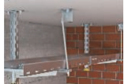
Einhängen der Gewindestange in den Brandschutzbügel
