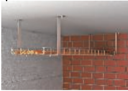
Einlagige Deckenmontage mit Abhängebügel
