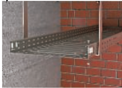
Befestigung der Kabelrinne mit Flachrundschauben
