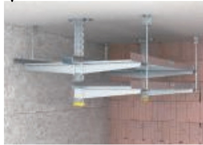
Deckenmontage mit beidseitiger Anordnung der Ausleger
