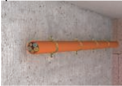
Waagerechte Montage der Kabel an der Wand
