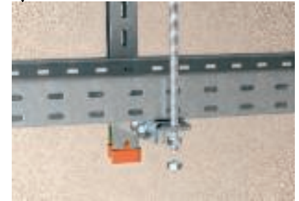
Montage der Gewindestangensicherung durch Anschlusswinkel an der Auslegerspitze
