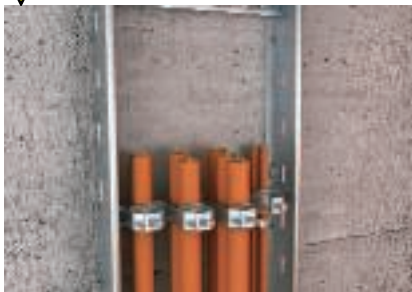
Befestigung der Kabel einzeln oder als Bündel mit Bügelschellen
