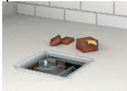
Zuschneiden von schmalen Streifen für die Kanalzüge
