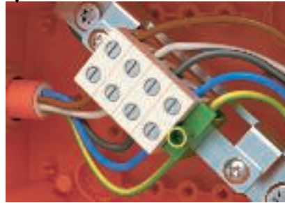
Ausführung mit 4 Klemmstellen und Schutzleiterklemme für Leistungskabel
