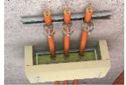
Wirksame Unterstützungsmaßnahme mit der Zugentlastung ZSE90
