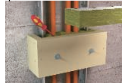
Mineralwolle-Füllung für flexible Kabelbelegung
