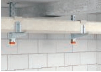
Abgehängte Deckenmontage als I-Kanal
