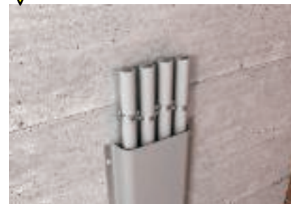
Befestigung der Bandage mit metallischen Schienen bei einer Einzelschelleninstallation
