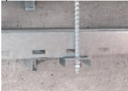
Befestigung der senkrechten Gewindestange am Anschlussbauteil
