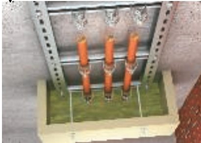
Wirksame Unterstützungsmaßnahme mit der Zugentlastung ZSE90
