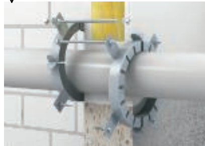
Exzentrische Anordnung mit max. 3 Stufen größeren Rohrmanschetten
