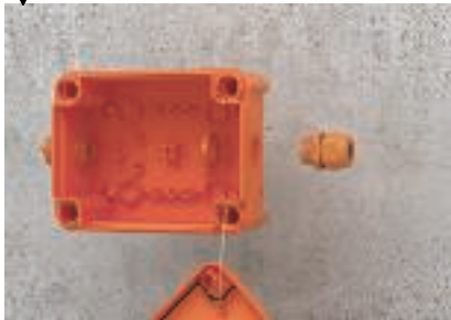
Kabeleinführung mit V-TEC Kabelverschraubungen
