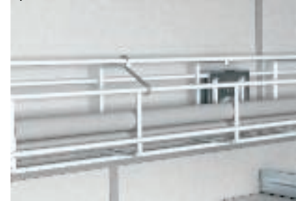
Sicherungshaken in korrekter Position
