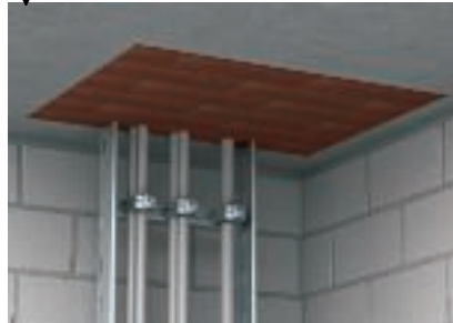
Strammsitzender Einbau der Blöcke im Deckendurchbruch
