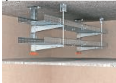
Zweilagige Deckenabhangung mit einseitiger Auslegeranordnung
