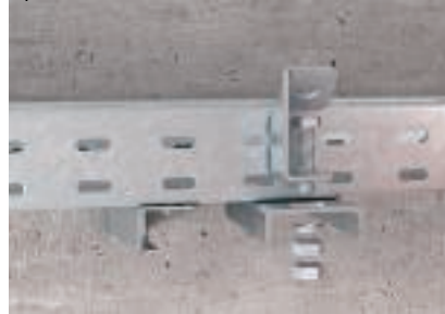
Befestigung des schrägen Anschlussbauteils
