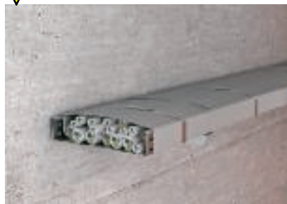
Komplette Umhüllung einer Kabeltrasse als Wandmontage
