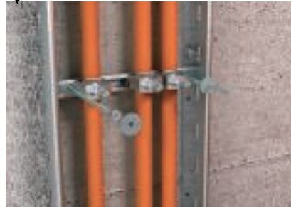
Befestigung mit Gewindestangen und Gleitmuttern in den Sprossen
