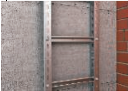
Direkte Montage der Steigeleitere an der Massivwand
