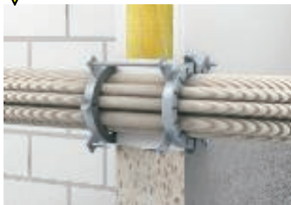
Beidseitige Anordnung der Rohrmanschetten bei Wandmontage
