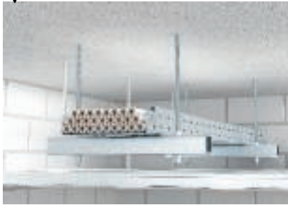
Einlagige Deckenmontage oberhalb abgehängter Brandschutzdecke
