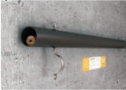
Einlegen in die Schraubabstandsschelle durch Einhaken des Ober- teiles unter die Schraube
