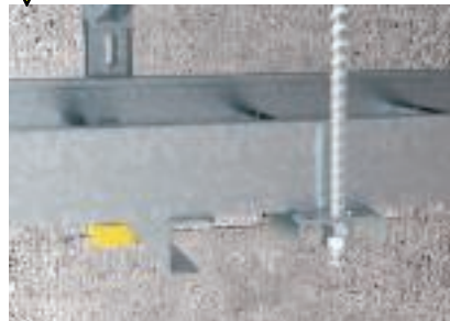
Anschlussbauteil im Abstand von max. 100 mm neben dem Ausleger
