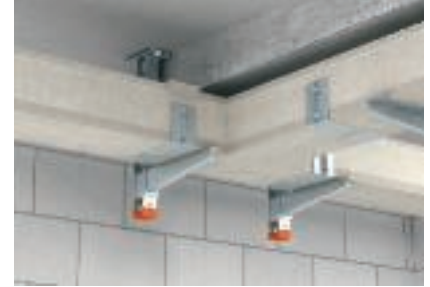
Vormontierte Standardformteile im Trassenverlauf
