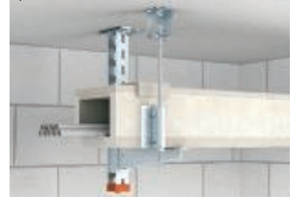
Montage als E-Kanal mit zusätzlicher Gewindestangensicherung
