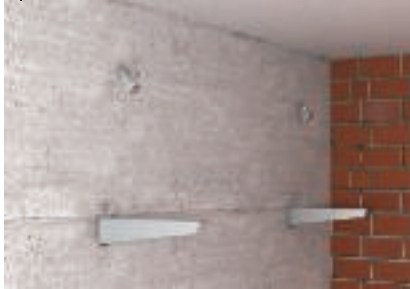
Montage der Ausleger und der Anschlussbauteile an der Wand
