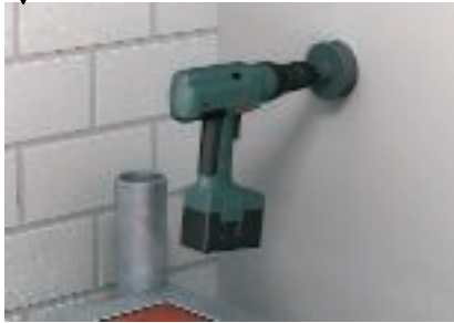
Bohren eines Lochs mit einem Dosenbohrer
