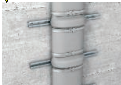
Befestigung der Bandage mit metallischen Spannbändern bei einer Schieneninstallation
