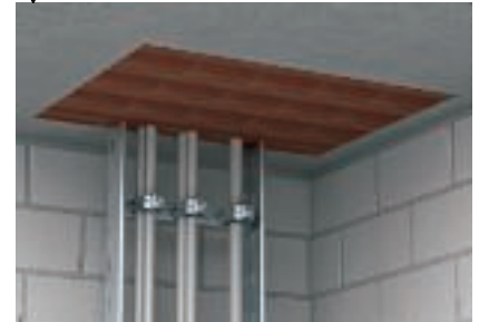
Strammsitzender Einbau der Blöcke im Deckendurchbruch
