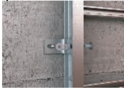
Montage mit verschraubten Befestigungswinkeln
