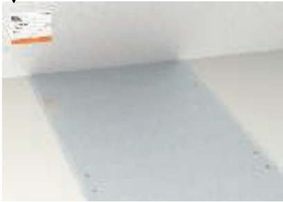
Unsichtbare Abschottung in estrichbündigen Unterflurkanälen
