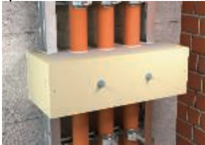
Wirksame Unterstützungsmaßnahme mit der Zugentlastung ZSE90
