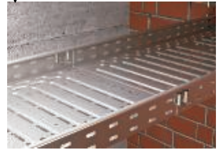
Stoßstellenverbindung ohne zusätzliche Verschraubung
