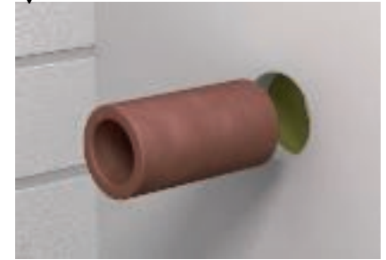
Einsetzen der Rohrschale in die leichte Trennwand
