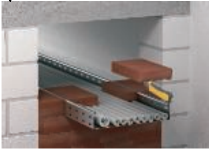
Montage der zugeschnittenen Blöcke
