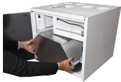
Kuva 8. Lämmöntalteenottokennon poistaminen.
